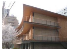
耐火建築物の事例
