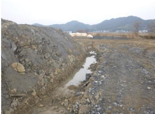
工事現場内に「沈砂池」を設置し、地区外への濁水流出防止に取り組んだ。
