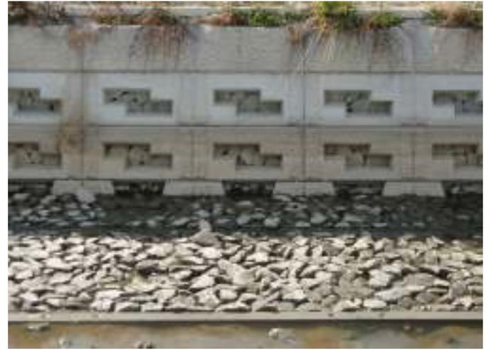
木工沈床—方格材の腐食はみられない
