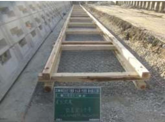
木工沈床施工状況ーブロック護岸の根固め工として採用
