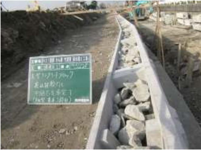
魚巢ブロック施工状況ーブロック内部に中詰石を充填
