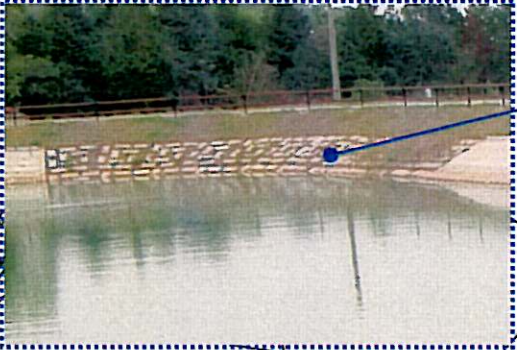
■多孔質の張りブロックによる池内環境配慮護岸整備
