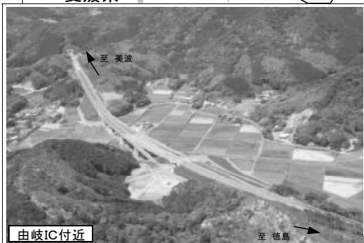
由岐IC付近 阿南安芸自動車道 日和佐道路H23全線完成予定
