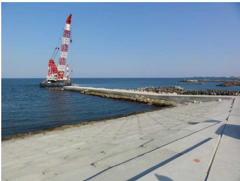
大型突堤施工状況
