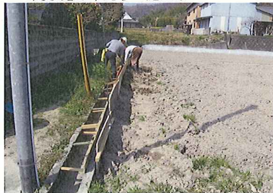
開水路の破損部分の補修 (水路側壁の破損部分の修繕)
