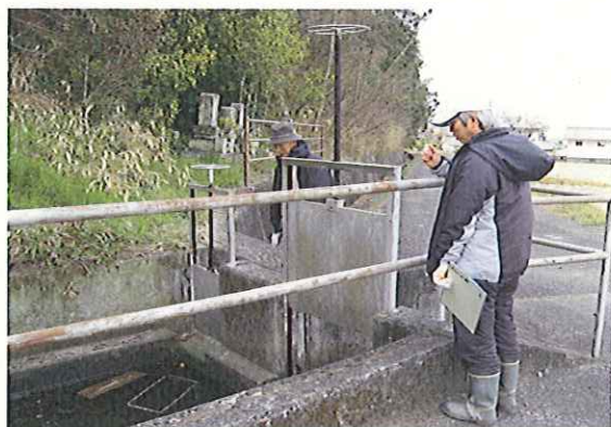
開水路の点検
