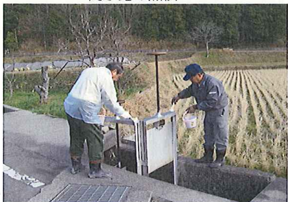
ゲートの管理 (開水路ゲートに腐食防止剤を塗布)
