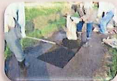
農道舗装の補修
