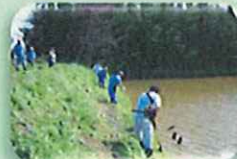
堤体の草刈り等によるため池の保安全管理
