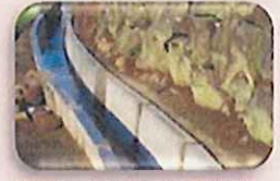
素堀り水路からコンクリート水路への更新
