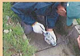
■ 水路の老朽化箇所の補修
