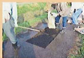
■ 農道舗装の補修
