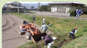
開水路草刈り・泥上げ
