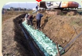
土のうを積み、法面を補修
