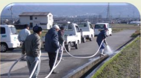
開水路の藻等の除去
