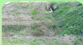
開水路の現況
