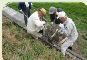
型枠を入れて簡易補修
