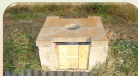
給水栓の凍結防止対策
