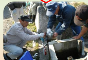
給水バルブを分解・修理
