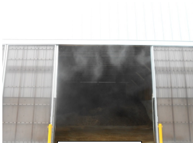
堆肥舎入口 (細霧装置稼働)
