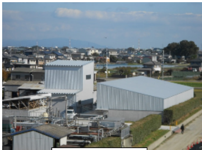
堆肥化施設全景
