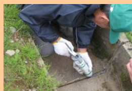
■ 水路の老朽化箇所の補修
