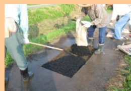
■ 農道舗装の補修
