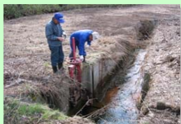
■ 点検・機能診断
