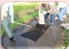
農道舗装の補修
