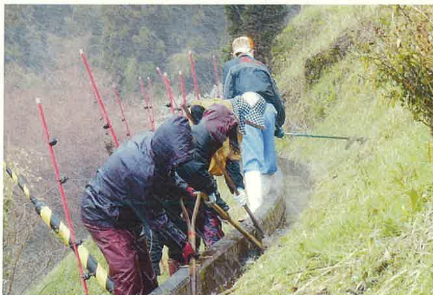
水路の泥あげ
