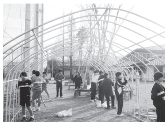
※骨組みの製作
