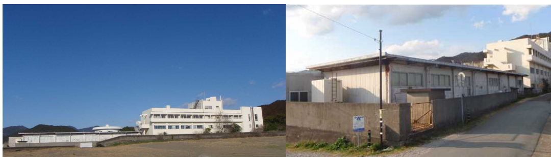
写真 1. 平成 28 年度中の竣工に向けて改築が進む水産研究課美波庁舎
