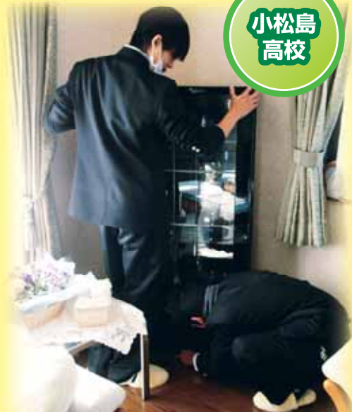
高齢者宅での耐震ゴムの設置
