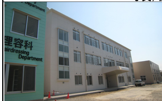
本館竣工写真
