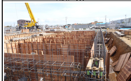
県産木製型枠
