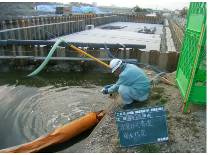
工事区域からの放流水の水質確認状況
