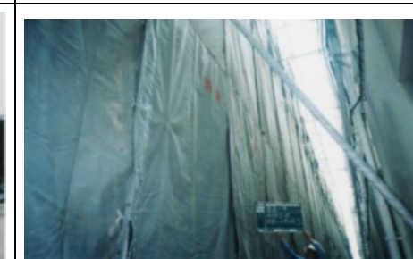
防音シート施工状況
