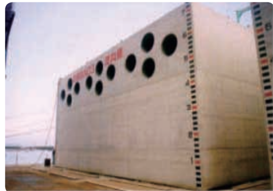
ケーソン出来形 2
