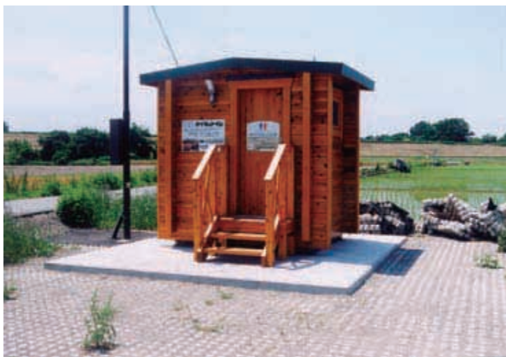
図 4-5 水を使わず、排水の出ないエコトイレ (出典) 埼玉県荒川・三ツ又沼ビオトープ
