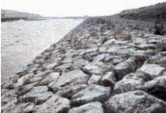
事業実施直後の空石積護岸
