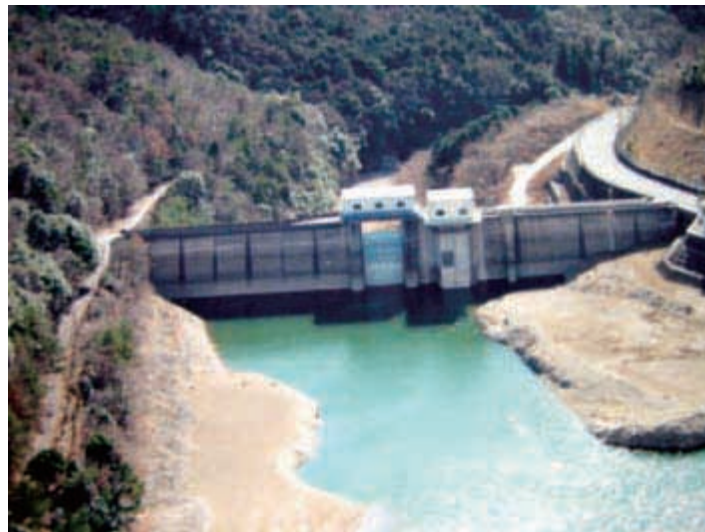
宮川内ダム（航空写真）
