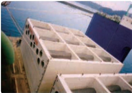
ケーソン出来形 1
