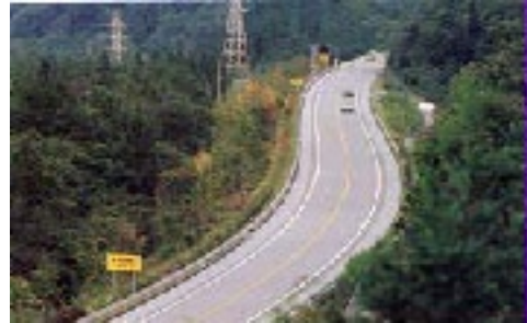
谷側に線形を振り縦断を下げ地形改変を最小にした造成
