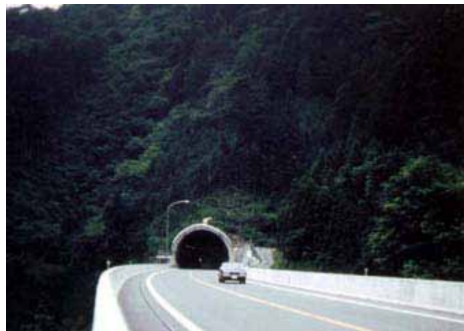
鳴虫山トンネル
