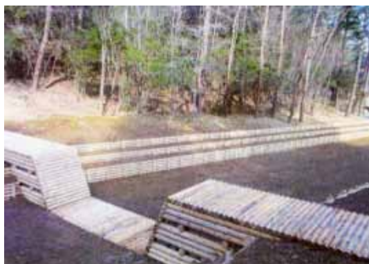
床固工・流路工
