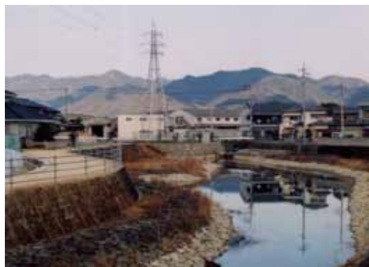
正法寺川（板野郡藍住町 河川課）
