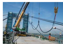
側径間斜ケーブル架設
