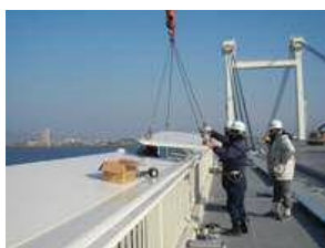
高欄にフラップ 設置
