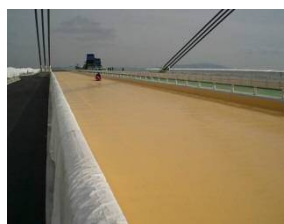
防錆材・接着剤を塗ってから ウルタ防水層を吹き付け
