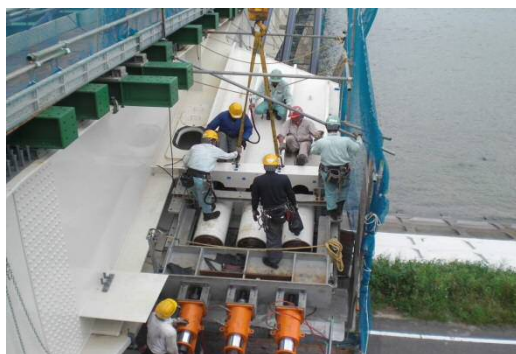
ケーブル緊張時(1000 t ジャッキ)
