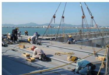
サントイッチ床版架設
