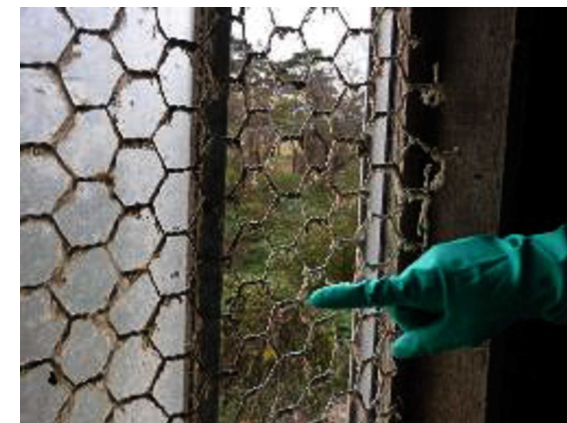
金網の穴が大きいため、常時小動物が通過し、そこだけホコリが付着していない。
