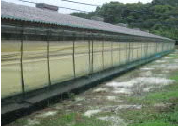
防鳥ネットの設置 鶏舎周囲の清掃・石灰散布
