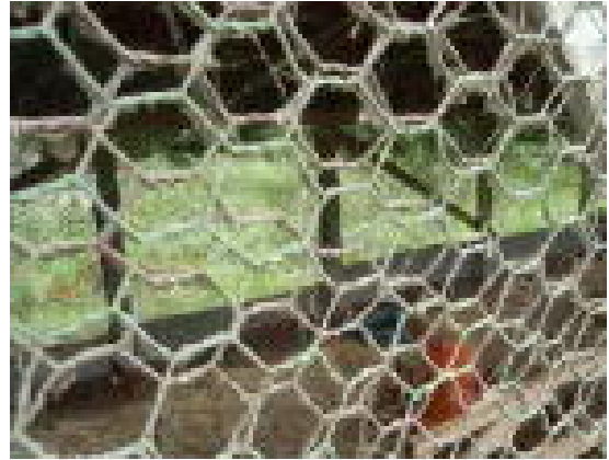
ネズミ、野鳥の侵入防止 ネットを二重に設置
