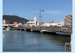
B45 中洲港橋
