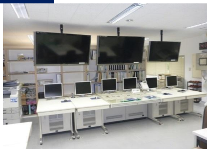
整備後 堰堤改良事業 正木ダム
