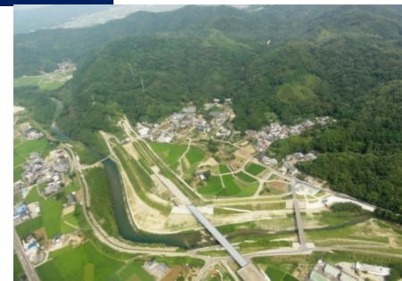
整備後 広域河川改修事業 園瀬川
