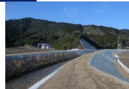
整備後 総合流域防災事業 奥湯川
