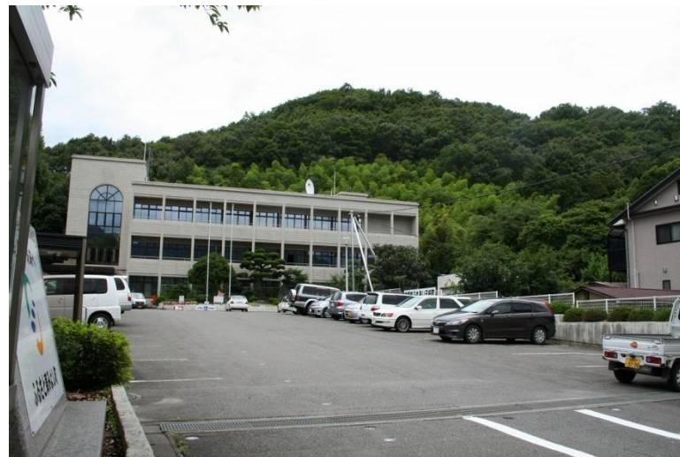
保全対象(東みよし町役場三好庁舎)
