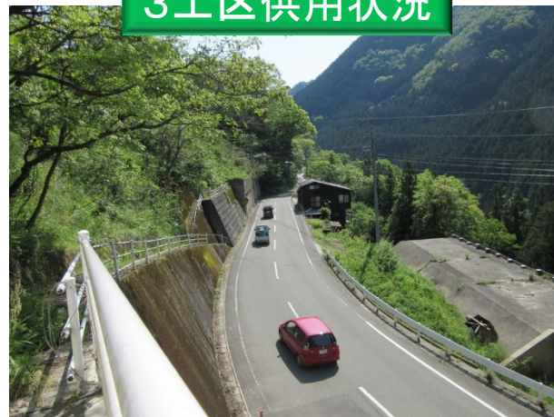
3工区供用状況
