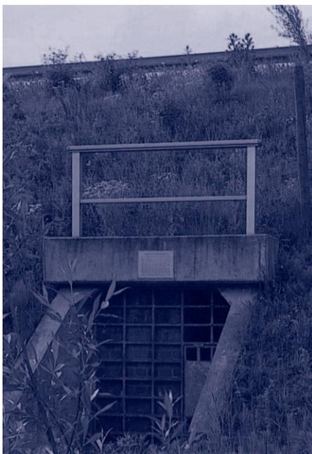
アウトバーンの法面につくられたコウモリのための洞穴。
