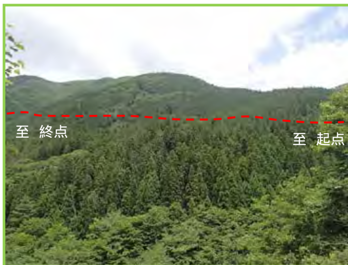
起点側からの計画地遠景
