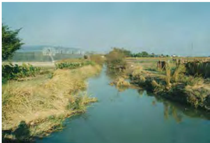
事業実施前の排水路の状況
