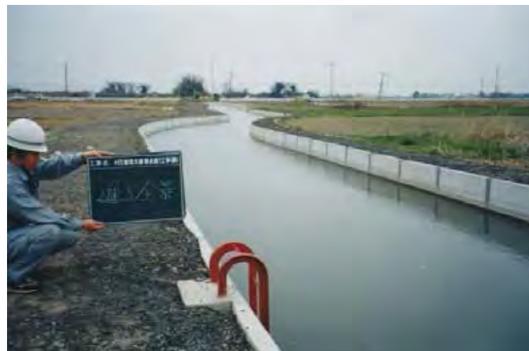
事業実施後の排水路の状況
