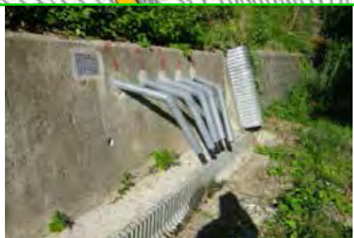
22号排水ボーリング工
