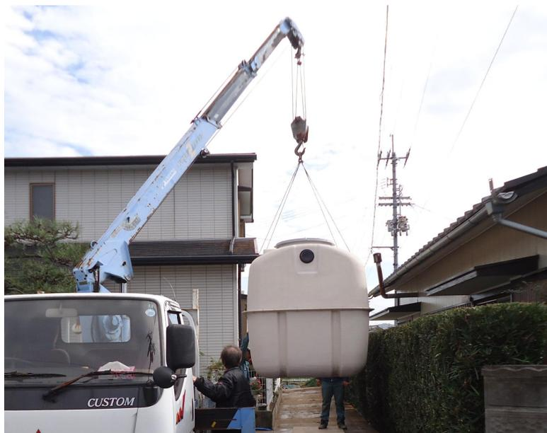
浄化槽の吊り上げ、吊り下ろしは4点で、吊り角は60°以下で！
