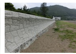
大浜海岸防潮堤
