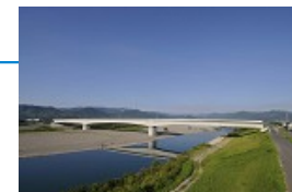
(仮称)新那賀川橋
