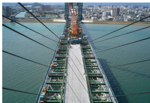
ストラット上から見た4段の仮ケーブル
