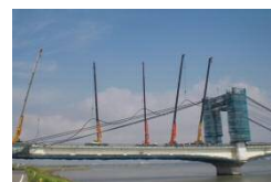
側径間斜ケーブル架設
