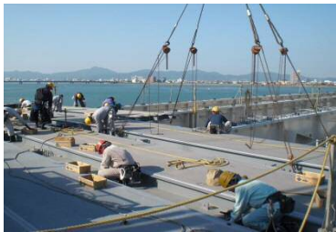
サントイッチ床版架設
