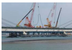
水平ケーブル架設
