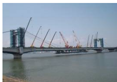
中央斜ケーブル架設
