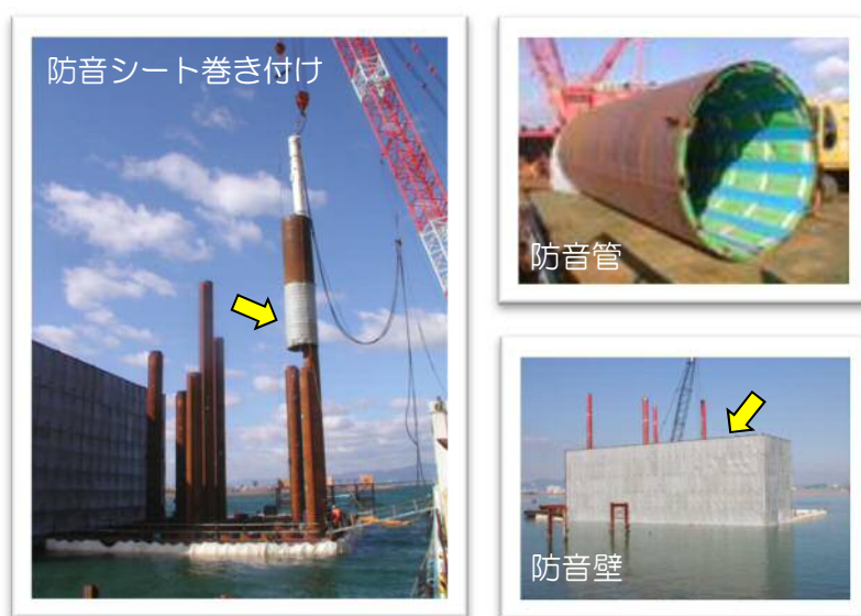
写真 3.2-1 騒音・振動対策
