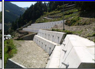
地すべり防止のための アンカー設置
