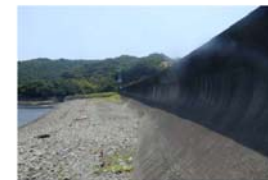
浅川港海岸での津波・高潮対策堤防
