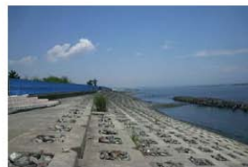
緩傾斜護岸（今切港海岸）
