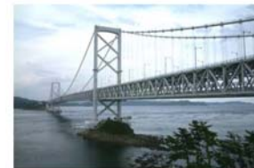
関西方面を結ぶ本四連絡橋
