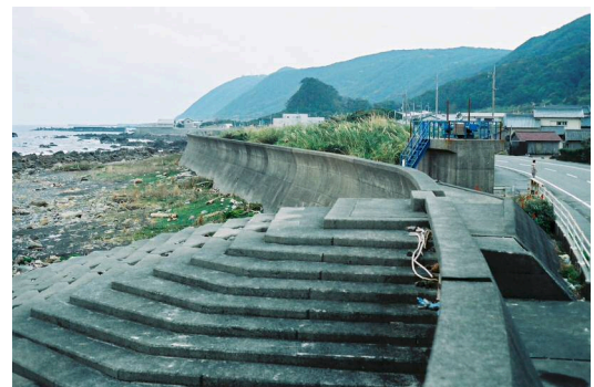
〔緩傾斜堤（室戸市丸山海岸）〕
