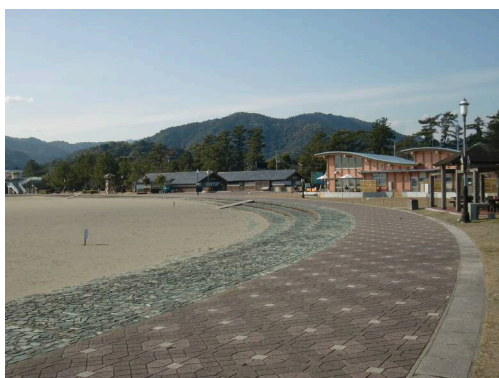
〔甲浦港海岸・白浜地区（東洋町）〕
