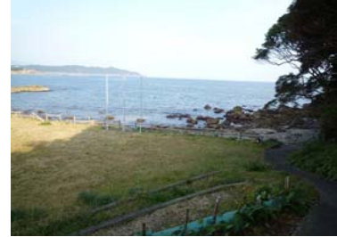
③護岸背後状況
