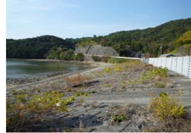
③護岸状況
