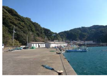
③護岸状況
