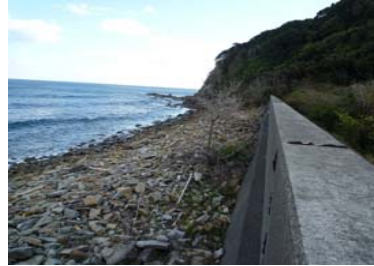
③護岸状況
