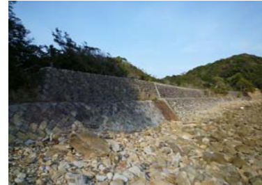
③護岸状況
