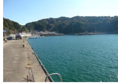
②護岸状況
