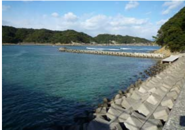
①護岸状況
