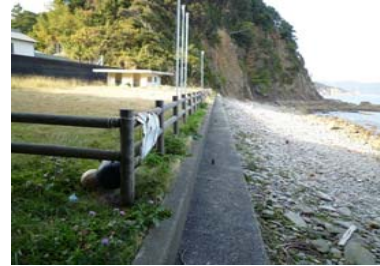
②護岸状況
