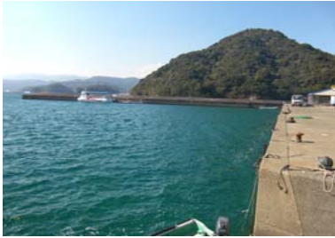
①護岸状況
