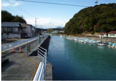
①護岸状況
