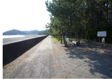
②護岸状況
