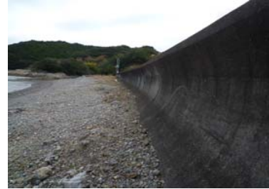
②護岸状況
