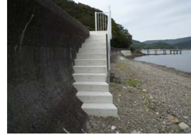
③護岸状況(階段工)
