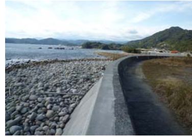
③護岸状況
