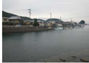
②護岸状況
