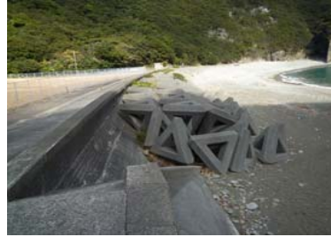
③護岸状況
