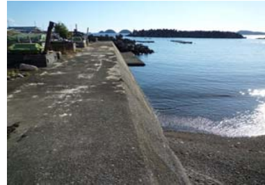
②護岸状況
