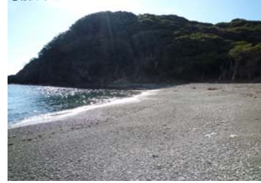
②護岸状況
