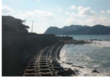
①護岸状況
