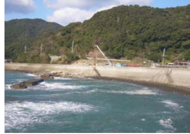
②護岸状況
