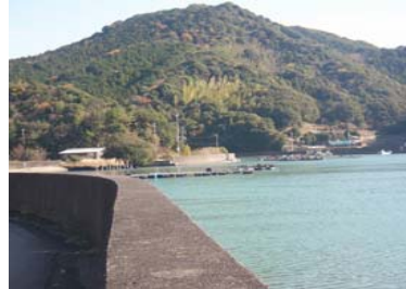
③護岸状況
