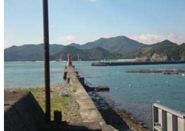
③突堤状況
