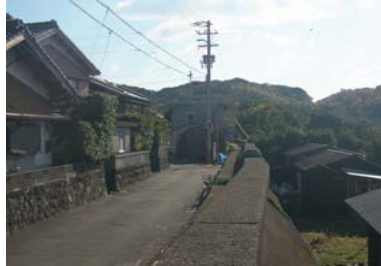
①護岸状況
