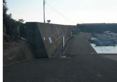
②護岸状況
