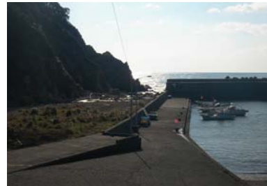
②護岸状況
