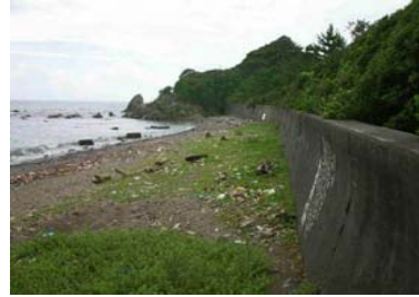
②護岸状況
