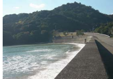
②護岸状況
