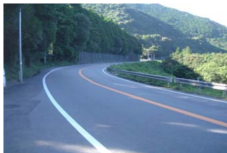
主要道路網である国道 55 号
