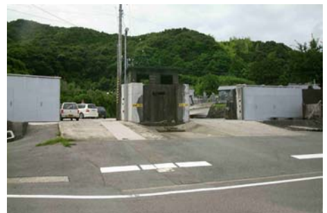
由岐漁港での 津波・高潮対策のための陸閘
