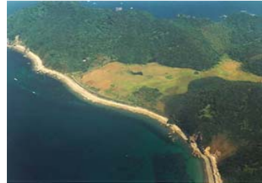
②護岸の状況
