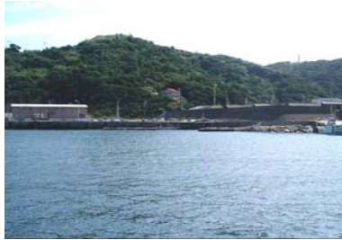
①海岸状況（全景）
