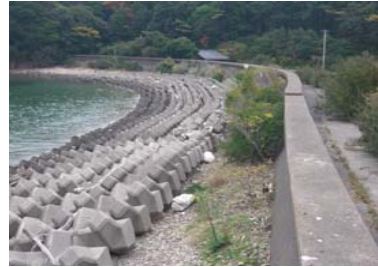
②護岸状況
