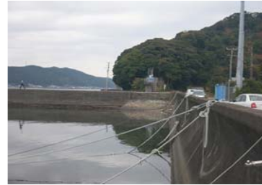
②護岸状況
