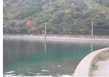
③護岸状況
