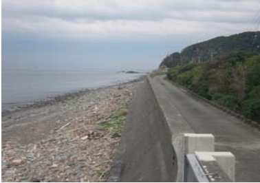
①護岸状況
