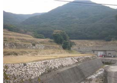
③護岸背後地状況
