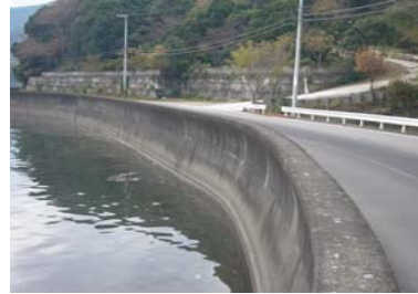
②護岸状況
