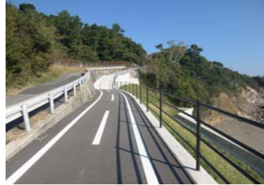
②護岸状況（サイクリングロード）
