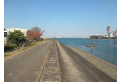
③護岸状況
