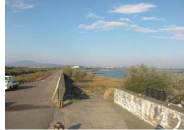
③護岸状況
