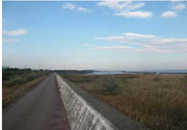
①護岸状況（西側を撮影）
