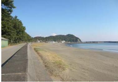
①海岸状況（全景）
