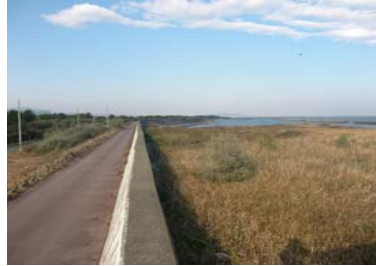
②護岸状況(東側)
