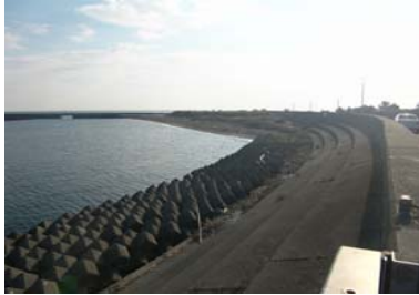
①護岸状況(東側)
