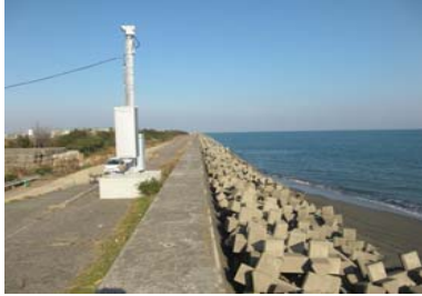
①護岸状況
