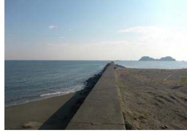
②突堤状況(最東側)
