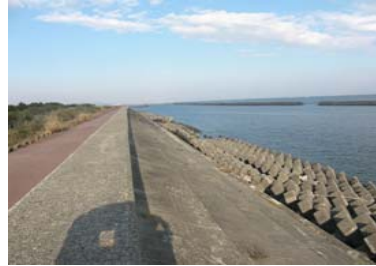
③護岸状況(西側)
