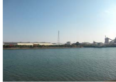
②護岸状況(埋立地東側)
