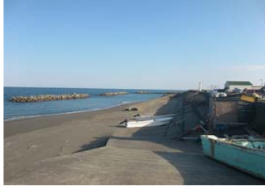
①護岸状況(北東側)
