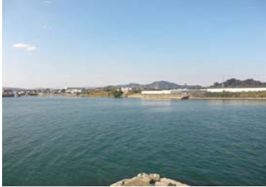
①岸壁状況(埋立地中央)
