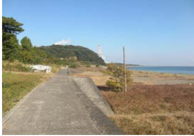
①海岸状況（全景）
