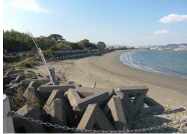
③護岸状況
