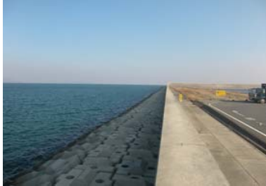
①護岸状況（東側）
