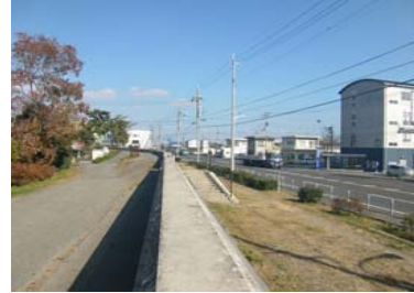
③護岸状況
