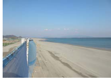
②護岸状況(北側)
