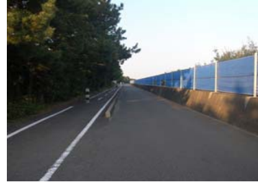
③堤防背後の管理道路と自転車道路
