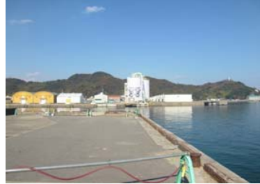
③護岸状況(南側)
