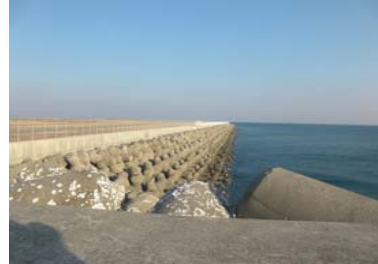
②護岸状況（南側）
