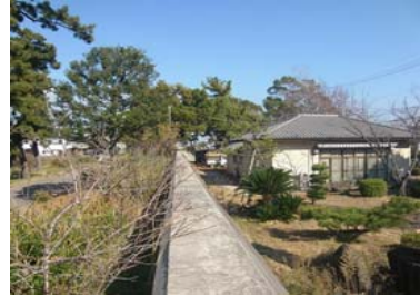
②護岸状況
