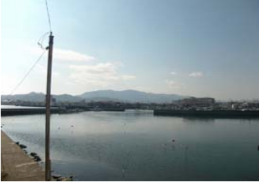
①護岸状況(全景)
