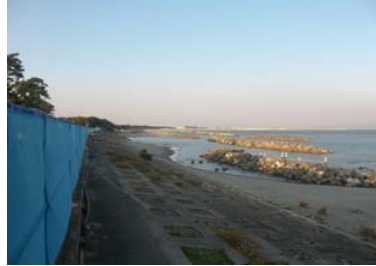
②護岸状況(北側)
