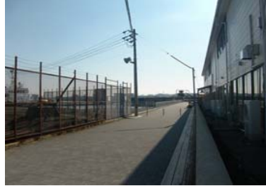
②護岸状況(南側)
