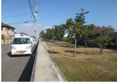
①護岸状況
