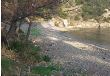
①護岸状況
