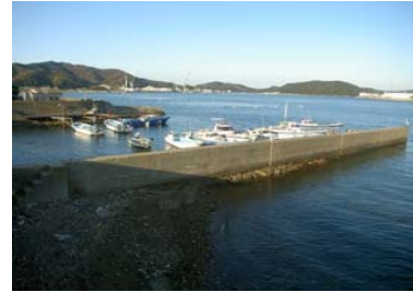
②護岸状況(その1最北側)
