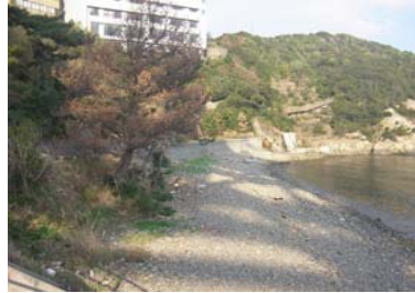
②護岸状況
