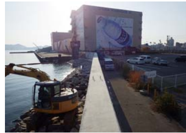
③護岸状況
