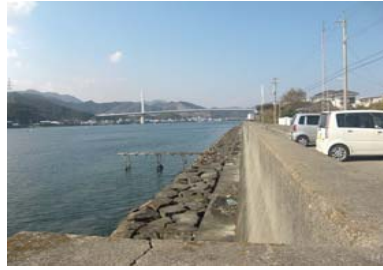
②護岸状況(中央)
