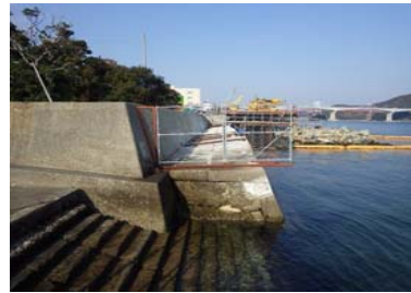
②護岸状況
