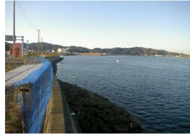
③護岸状況(その1南側)
