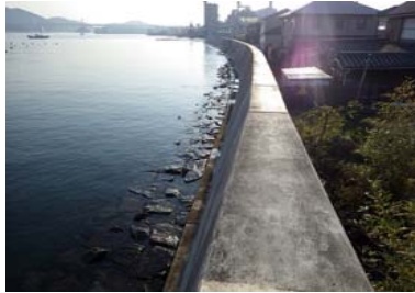
①護岸状況
