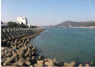
①護岸状況(階段護岸・管理棟)
