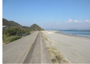
③護岸状況
