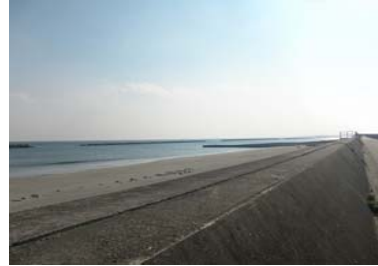
②護岸状況(北側)
