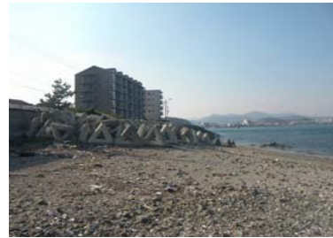
③護岸状況(東側)
