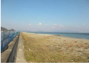
①護岸状況(南側)
