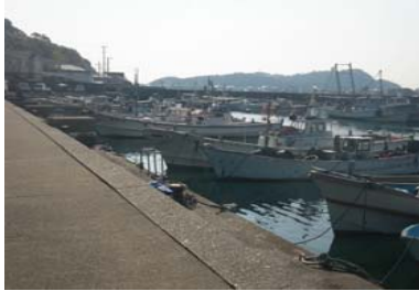
①護岸状況（西側）
