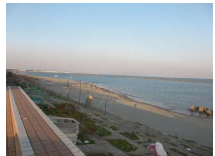
今切港海岸の緩傾斜護岸
